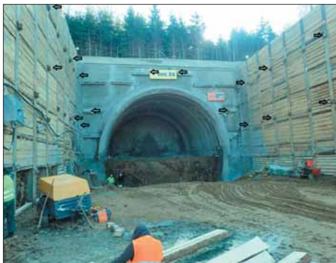
Obr. 7 Pohled na výjezdový portál s osazenými 3D geodetickými body a dynamometry
