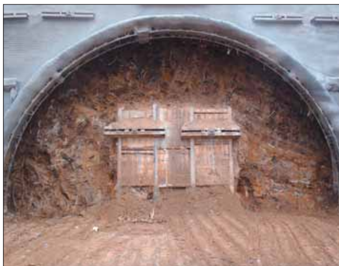
Obr. 3 Čelba v TM 49,4 – výjezdový portál, zahajovací čelba ražené části tunelu Fig. 3 Excavation face at TM 49.4 – exit portal, opening excavation face of the mined tunnel part
