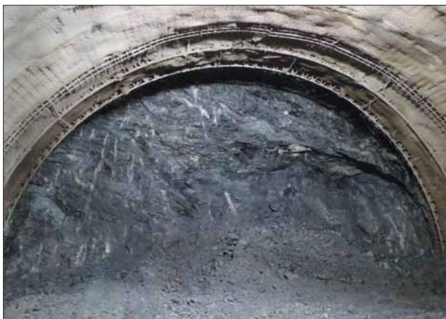
Obr. 9 Čelba v TM 378,8 – centrální partie zlomového pásma, patrná je extrémní deformace, zvrásnění, tektonické ohlady či extrémně malá vzdálenost diskontinuit Fig. 9 Excavation face at TM 378.8 – central area of a fault zone; extreme deformation, folding, tectonic slickensides or extremely small spacing of discontinuities are visible
