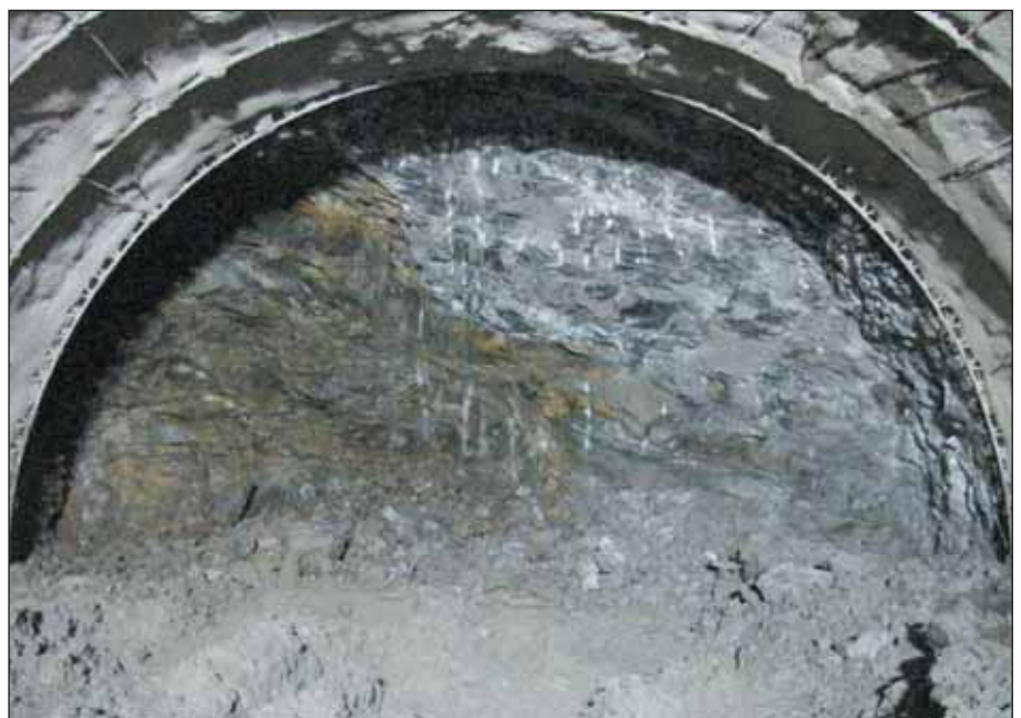
Obr. 7 Čelba v TM 344,5 – rozhraní nastupující zlomové zóny (vlevo) a zdravých pararul Fig. 7 Excavation face at TM 344.5 – interface between onsetting fault zone (left) and fresh paragneiss
