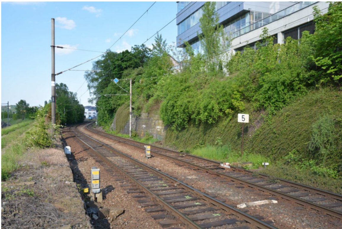
Obrázek 6 Zárubní kamenná zed podél vlečky ČD Praha Libeň, v popředí staniční kolej 900. napojující depo do železniční stanice Praha-Libeň
