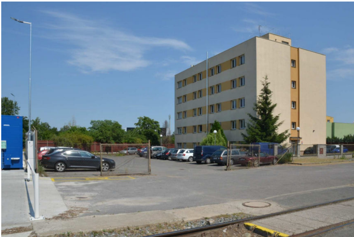
Obrázek 10 Parkoviště ČD OCÚ Střed (depo Libeň), kterým má procházet účelová komunikace k pozemním objektům obvodu Malletova. V pozadí budova Správy železnic, Centra telematiky a diagnostiky
