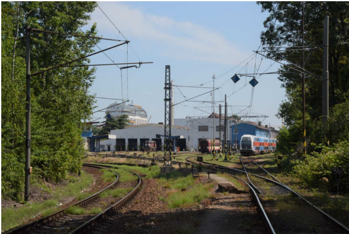
Obrázek 9 Vlevo kolej 900., která se stane traťovou kolejí Praha-Libeň – Praha hl. n. obvod Malletova. Vpravo vlečka ČD Praha Libeň se zhlavím depa, navržené úpravy končí před krajní výhybkou
