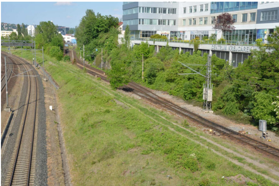
Obrázek 4 Pohled z estakády ulice Pod Plynojemem po směru staničení obvodu Malletova. Vlevo 401. TK, 302. TK, uprostřed prostor navrženého kolejiště, vpravo trať směr Praha-Libeň a vlečka ČD Praha Libeň, nad ní komerční Centrum Krejčárek
