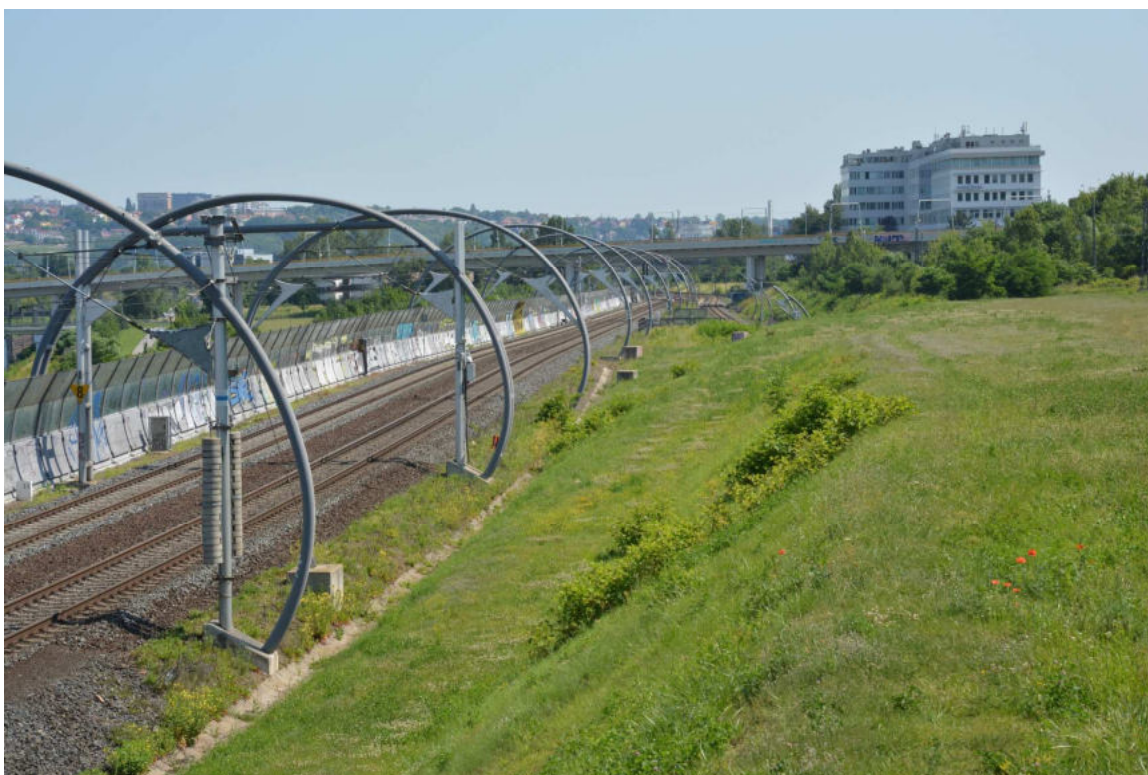
Obrázek 2 Pohled vpřed z nového km 0,000 obvodu Malletova. Vlevo trať Praha hl. n. – odb. Balabenka, do jejíž pravé koleje bude vložena výhybka 303. Louku ve středu snímku zabere zhlaví nového kolejiště
