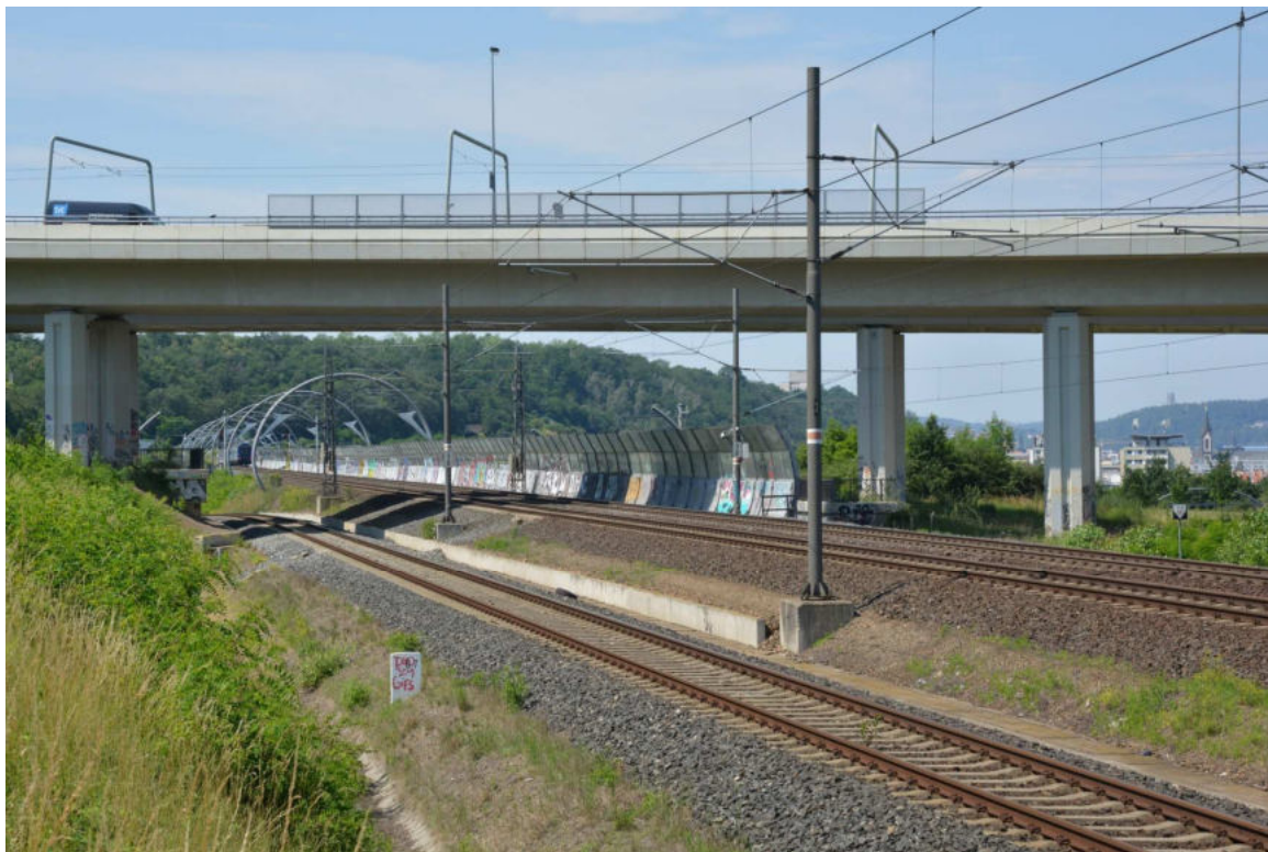
Obrázek 7 Souběh tratí odb. Balabenka – Praha Masarykovo nádraží (401. TK) a odb. Balabenka – Praha hl. n. (302. a 301. TK), nad nimi dvojice souběžných estakád ulice Pod Plynojemem a tramvajové trati. Do koleje 401. v popředí bude vložena nová výhybka 1, napojující kolejiště Malletova
