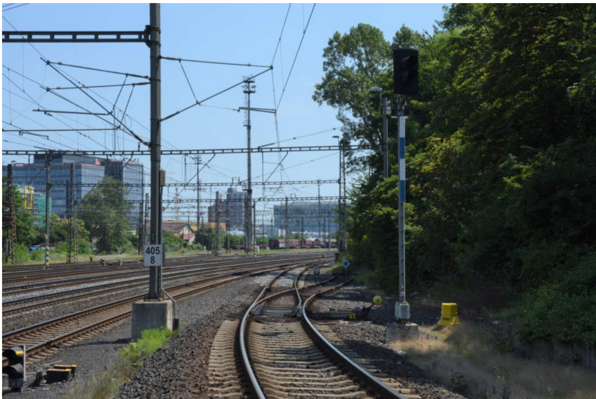
Obrázek 12 Konec stavby v místě napojení do žst. Praha-Libeň. V popředí úsek z pražců B91S/1 a kolejnic 49E1 s výhybkou 89, oboje z roku 2008. Kvůli zvýšení rychlosti na 50 km/h bude tato výhybka rekonstruována. V pozadí zapojení koleje obloukovou výhybkou 75
