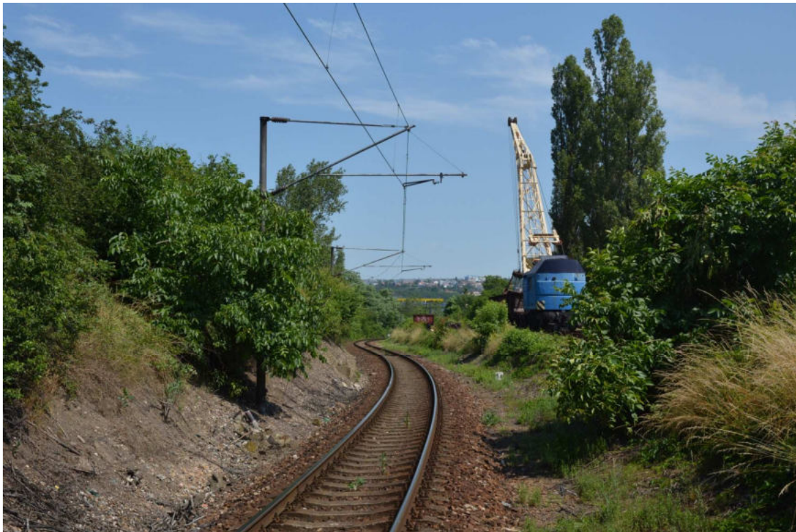
Obrázek 11 Kolej 900., která se stane traťovou kolejí Praha-Libeň – Praha hl. n. obvod Malletova. Pohled z km 1,000 zpět k Libni
