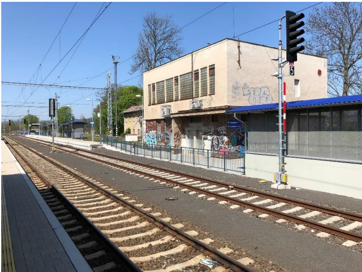
Pohled ze středního perónu směrem k 1. nástupišti na technologický objekt, v popředí vpravo přístřešek schodiště podchodu.
