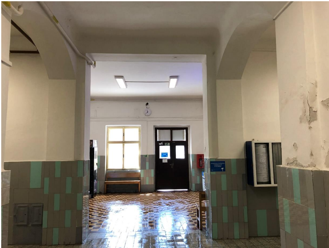
Vstupní hala, pohled od vstupu z ulice Nádražní.
