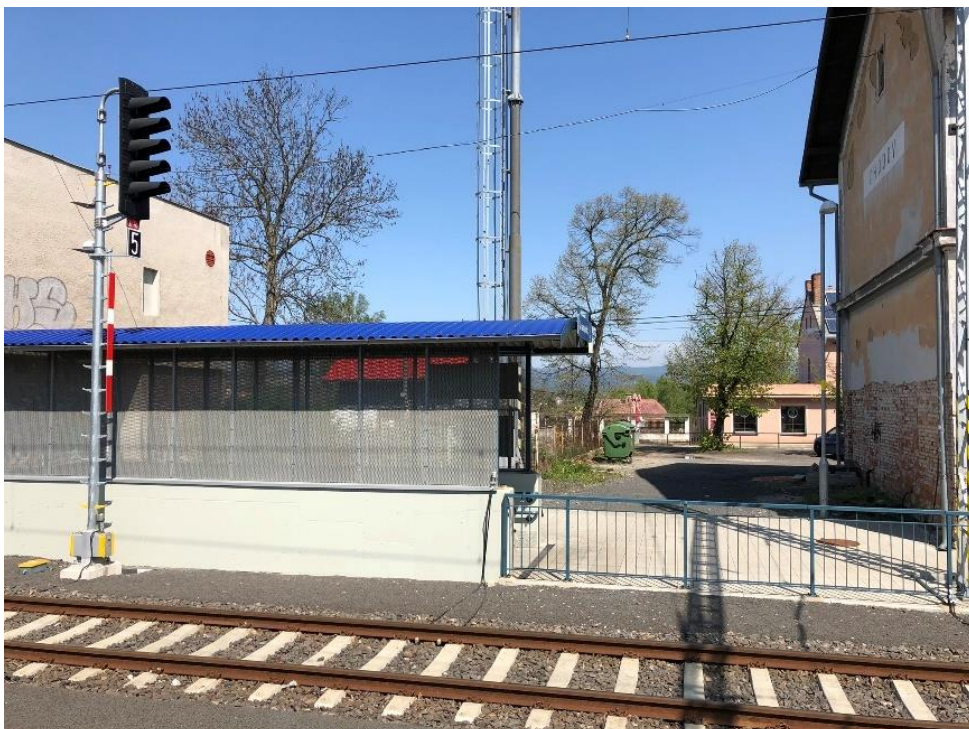
Přístřešek nad schodištěm k podchodu vedoucím na ostrovní perón ve vazbě na stávající budovu.
