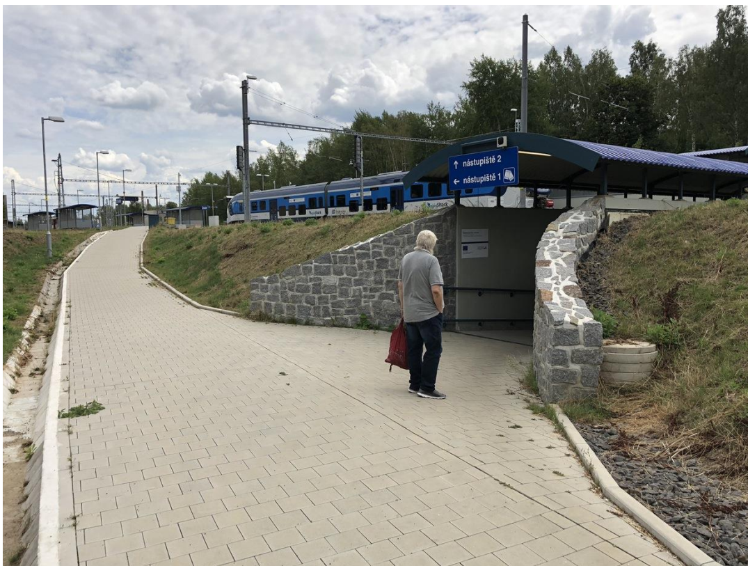
Detail nástupu do podchodu ve vazbě na šikmý průběh pěší komunikace, a ne příliš šťastné uspořádání rozptylové plochy přednádražního prostoru.
