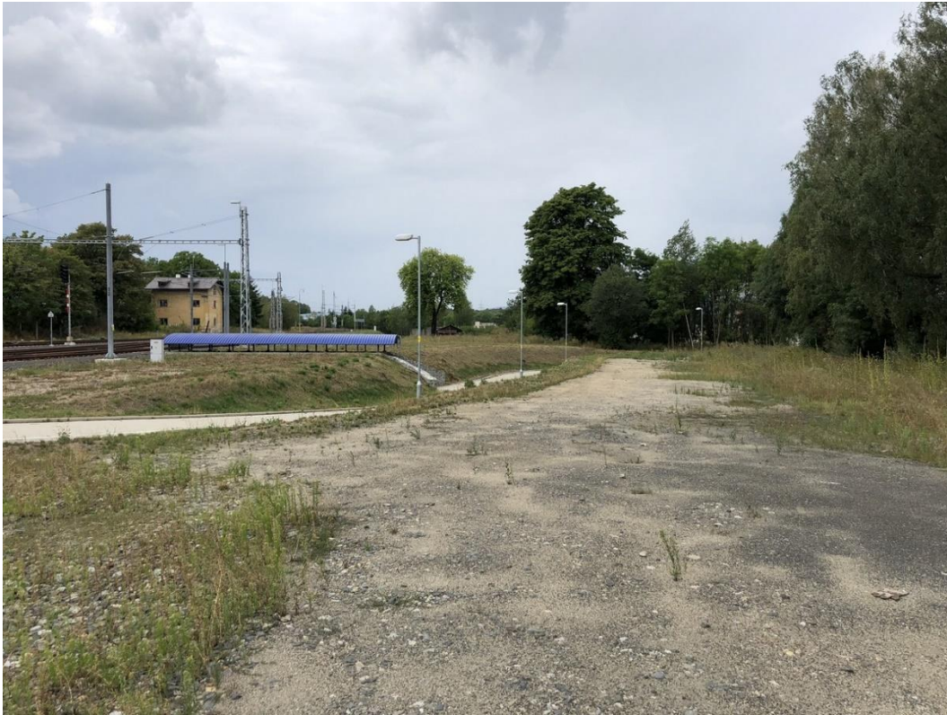
Pohled od technologického objektu přes budoucí parkoviště směrem k místu pro novou VB.
