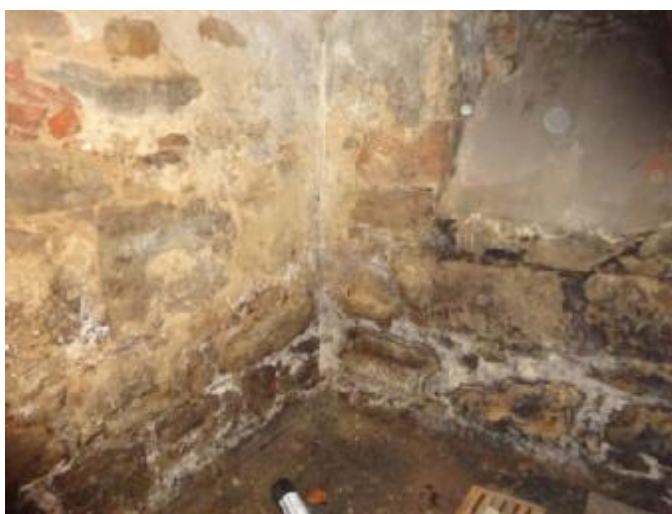
Provedení kamenného zdiva
