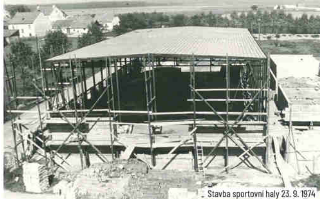
Stavba sportovní haly 23. 9. 1974
