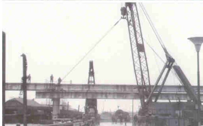
Foto po opravě
