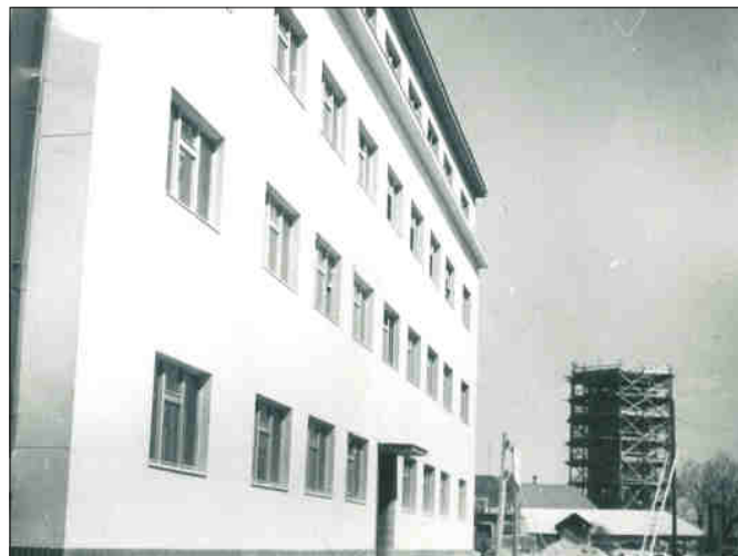
V dubnu 1947 už byla postavena admin istrativní budova V zadu se ještě opravuje vodárenská věž
