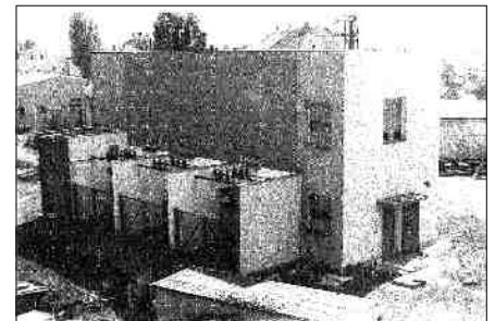
Nová trafostanice postavená v roce 1970.
