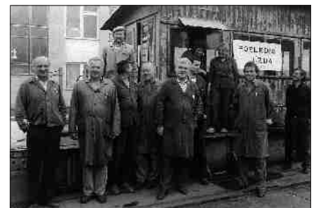
Mistři z vozovky na staré vozové přesuvně při její poslední jízdě dne 10. 5. 1994. Uprostřed je vedoucí vozovky K. Laňka.
