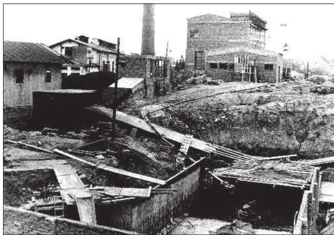
Výstavba kotelny. V popředí stavba hlubinného zásobníku. V pozadí už stojí nová budova kotelny.
