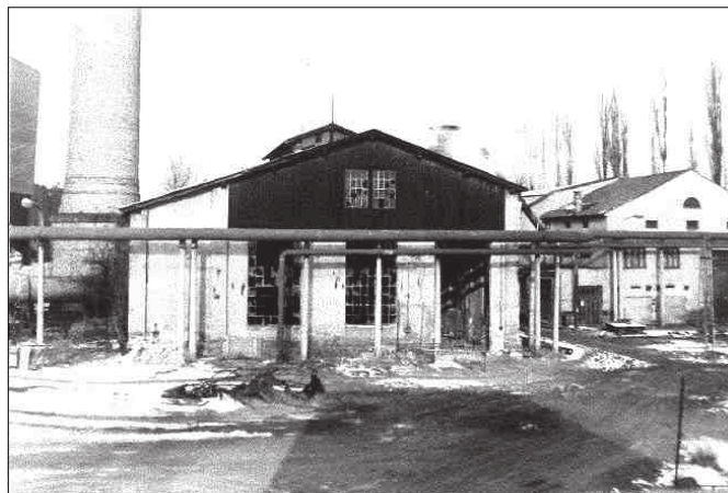
Stará kotelna před začátkem přestavby na elektrikářskou dílnu. Vpravo je truhlárna.
