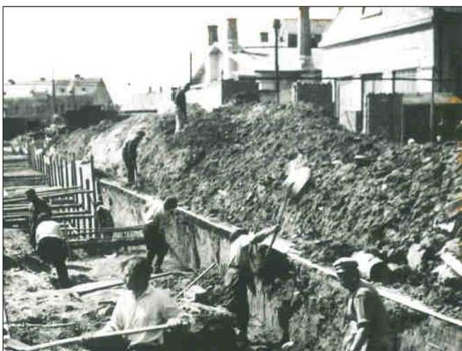
Budování základů nové lokomotivky
