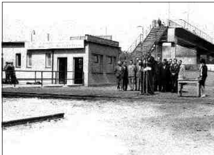
Zahájení provozu na přechodové lávce 25. 8. 1972. Nápis na vrátnici zní: "Sdružený soc. závazek + racionalizační úsilí = otevření stavby 3 měsíce před termínem.
