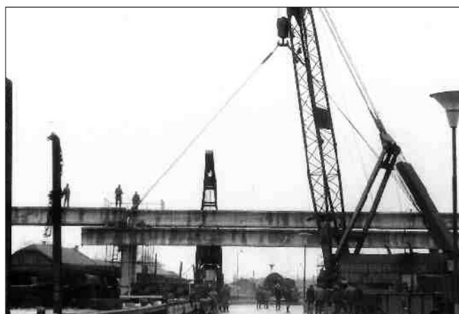
Výstavba lávky - listopad 1971
