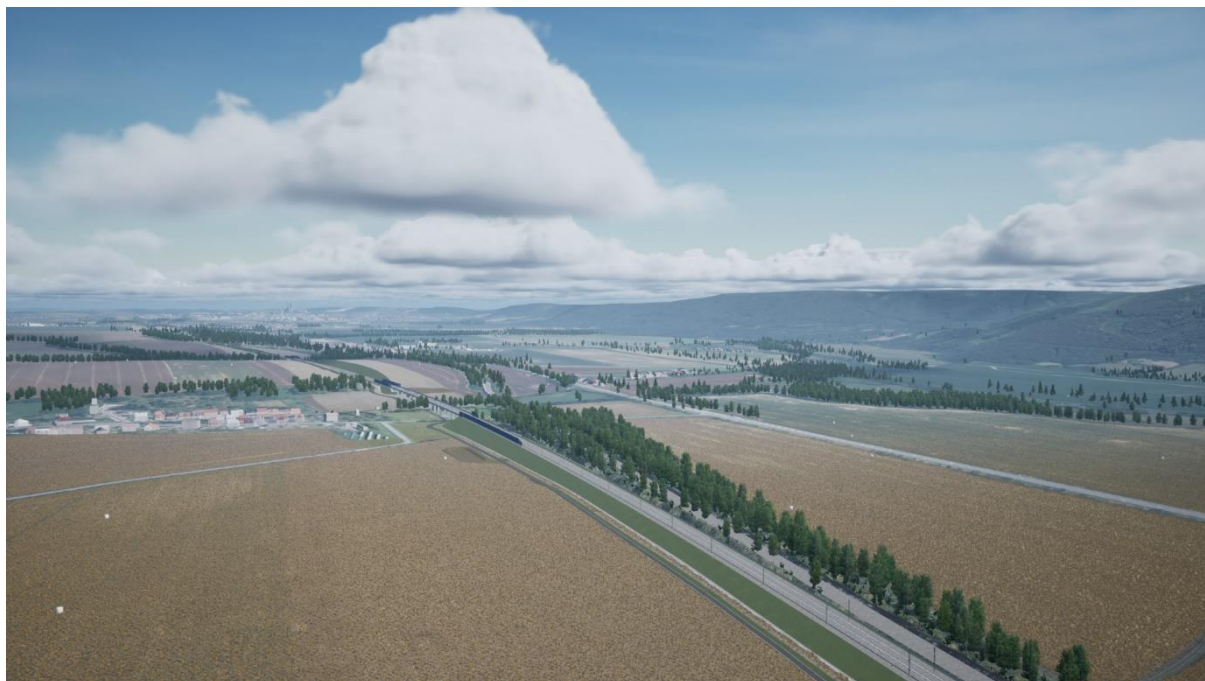
Obr. 108 Jezernické viadukty, v pozadí horizont Maleníku
